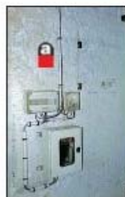
▶ Dans le plâtre amiante
