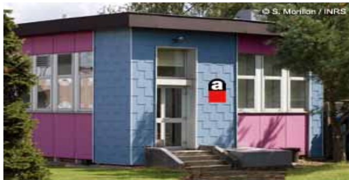
Dans les bardages de façade en amiante-ciment
