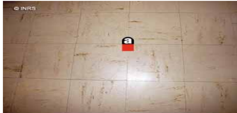
Dans les dalles de sol en vinyl-amiante
