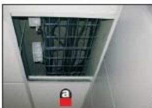
◀ Dans les faux plafonds
