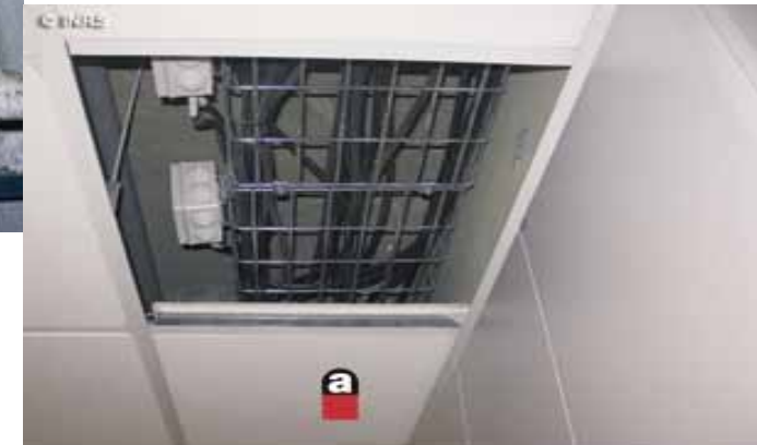
Dans les faux plafonds
