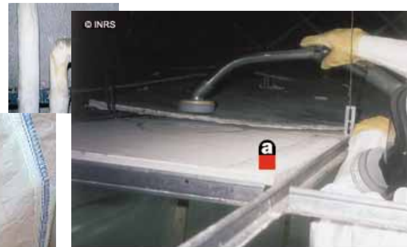
Dans les faux-plafonds
