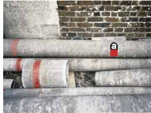
Dans les canalisations en amiante-ciment
